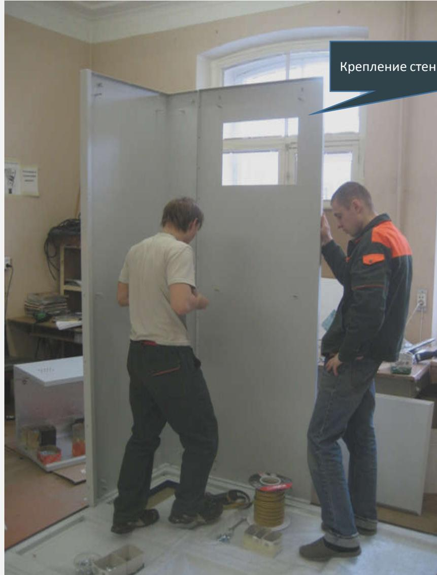
Крепление стенки заднего модуля
