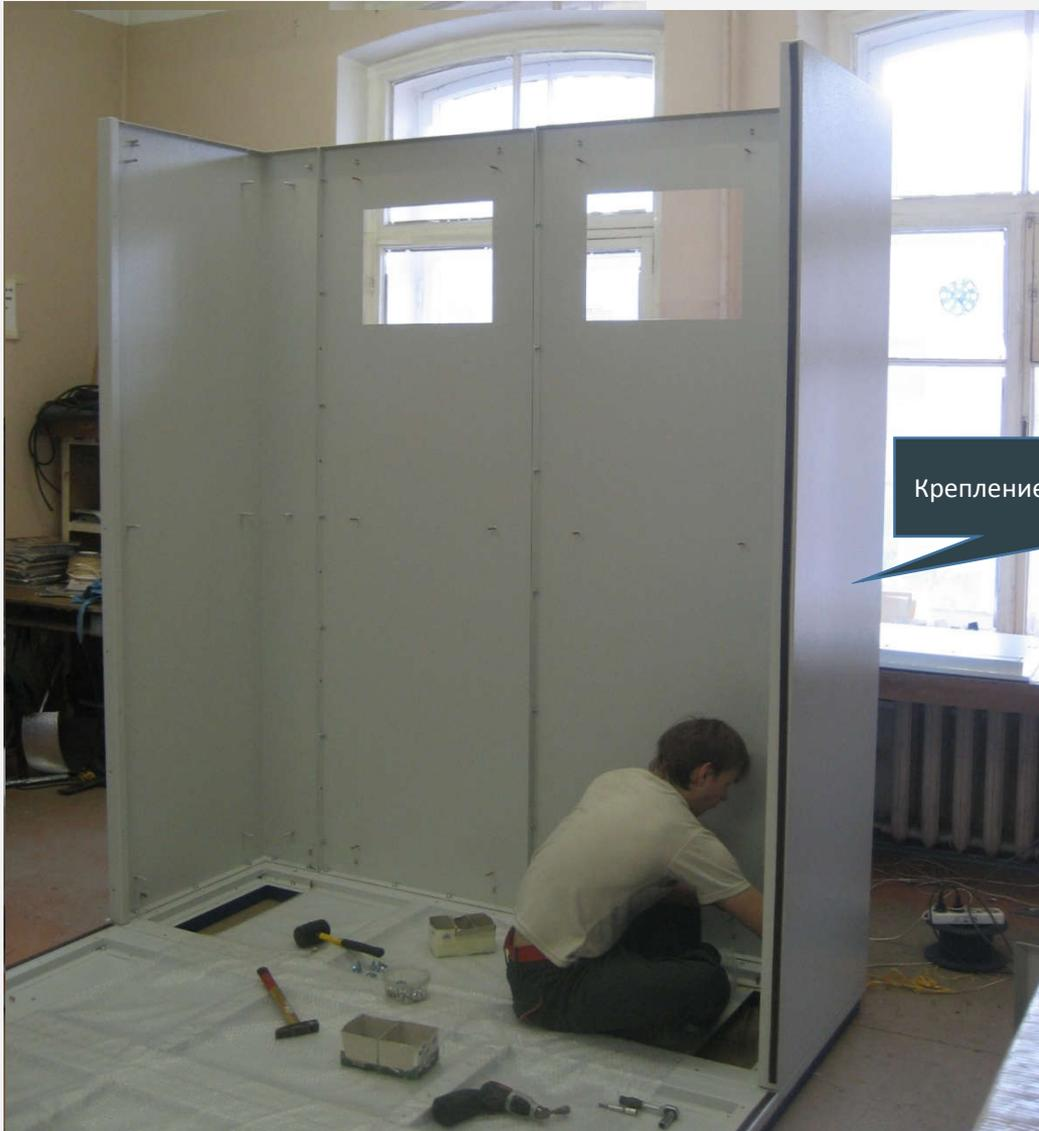
Крепление стенки заднего модуля
