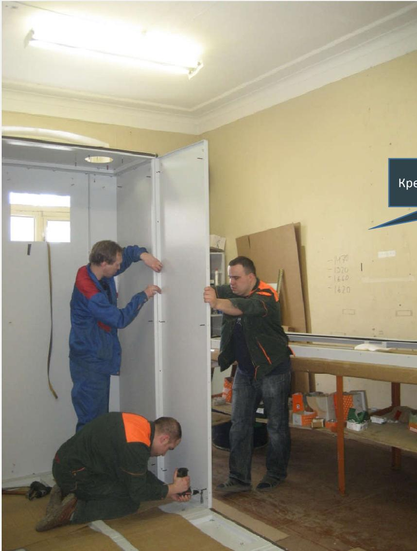
Крепление стенок модуля
